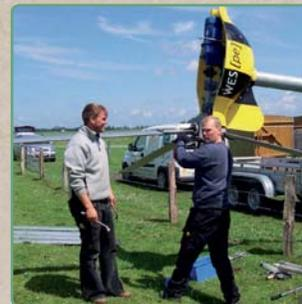
Eine Wartung ist nur zweimal jährlich notwendig. Die WESpe 5.0 wurde so konzipiert, dass nur ein Mindestmaß an Wartungsaufwand entsteht. Sie kann vom Betreiber selbst durchgeführt werden oder wird von der WES energy GmbH als Service angeboten. Die Anlage ist komplett umlegbar und die Wartung kann dadurch problemlos vom Boden aus durchgeführt werden.
